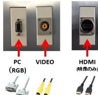
壁にあります端子板に持込機器と接続しまして、出力したいソース系を選択してください。
